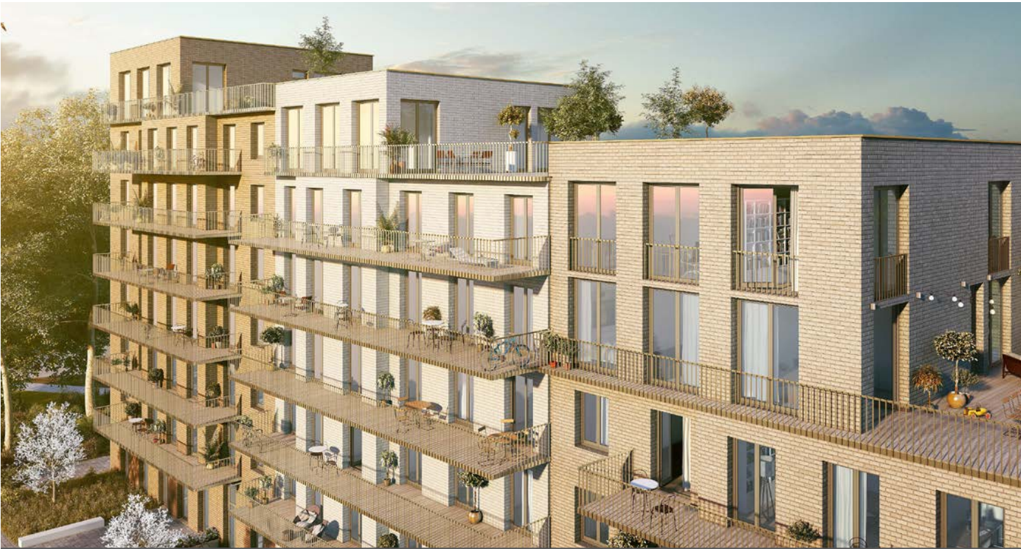
STATIONSHUSEN VÄSTRA ROSLAGS-NÄSBY
